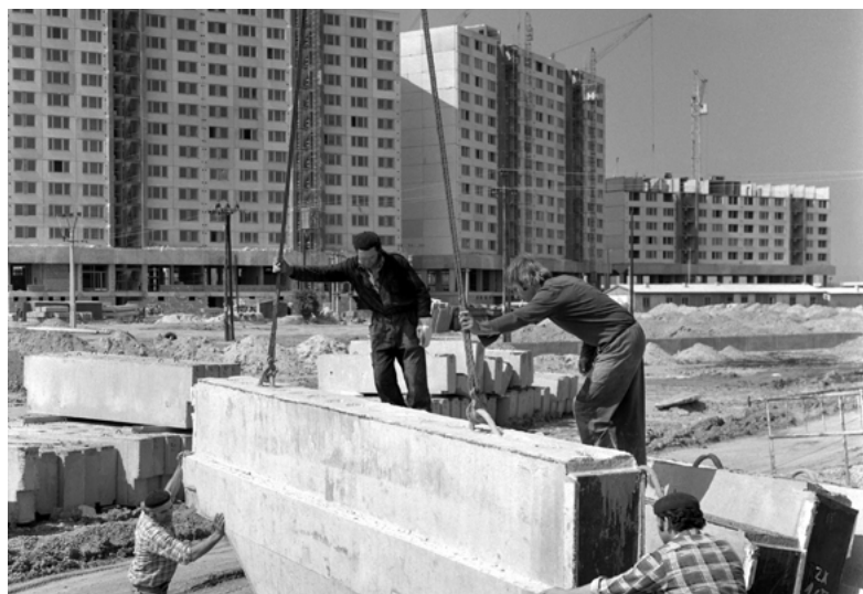
01 • Prebiehajúca výstavba na novom petržalskom sídlisku v roku 1980
