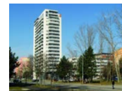
12 • Polyfunkčný komplex Dominant; nám. Hrančiarov
