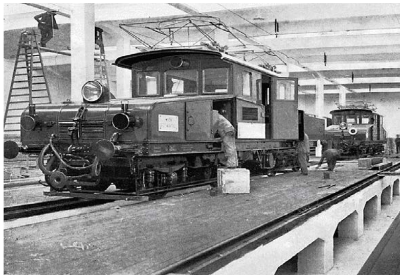
33 • Remíza — vozovňa električky do Viedne
