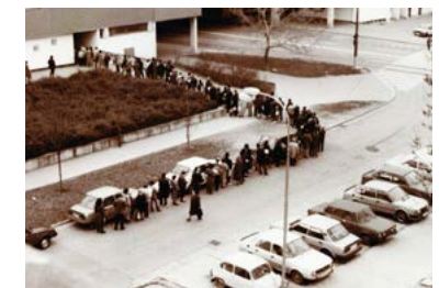
22 • Obchodný dom počas výstavby a slávnostného otvorenia. Pohľad do interiéru a potravín
