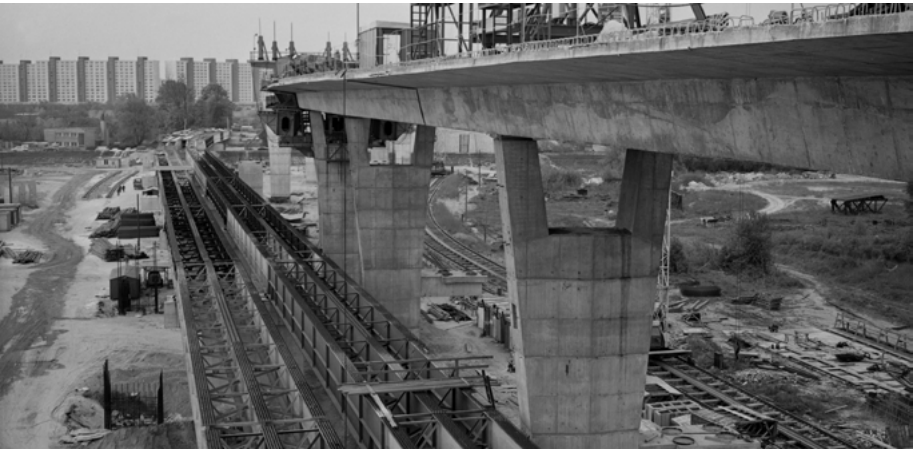
09 • Pohľad na most počas výstavby v r. 1981
