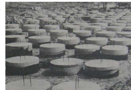
07 • Celé sídlisko je kvôli vysokej hladine spodnej vody postavené na betónových pilótach
