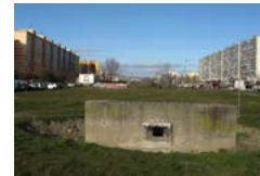
72 • Protitanková stena na Jantárovej ulici
