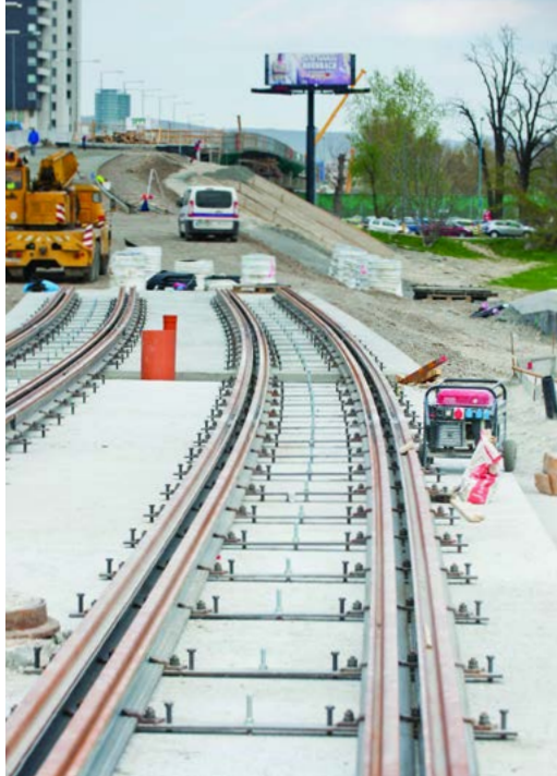
20 • Výstavba električkovej trate v Petržalke; 2015
