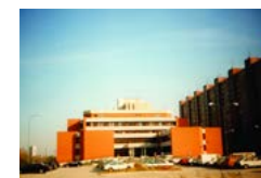
13 • Na Námestí hraničiarov otvorili v roku 1994 novú budovu polície.
