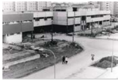
Obchodný dom počas výstavby a slávnostného otvorenia
