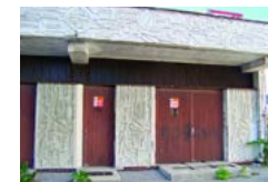
Geometrické reliéfy; Trafostanica, Bulíkova 27 Autor: Nezistený, koniec 70. rokov 20. stor.
