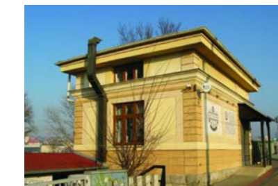
28 • Mýtny domček pri Starom moste
