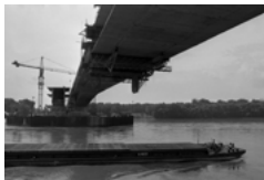
12 • Most počas výstavby v auguste 1989
