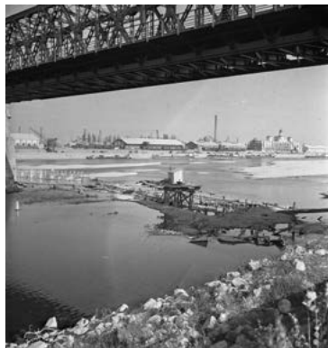
26 • Sucho v roku 1947 sa prejavilo aj na nízkej hladine Dunaja. Pokles hladiny napríklad odhalil zvyšky konštrukcie Starého mosta zničeného ustupujúcou nemeckou armádou.
