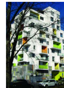
14 • Polyfunkčný dom Nový háj
