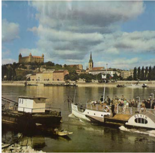
53 • Petrážské nábrežie pred výstavbou Mosta SNP
