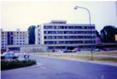
28 • Ako posledné otvorili zdravotné stredisko na Fedinovej u. v roku 1991. Pohľad na budovu krátko po otvorení.
