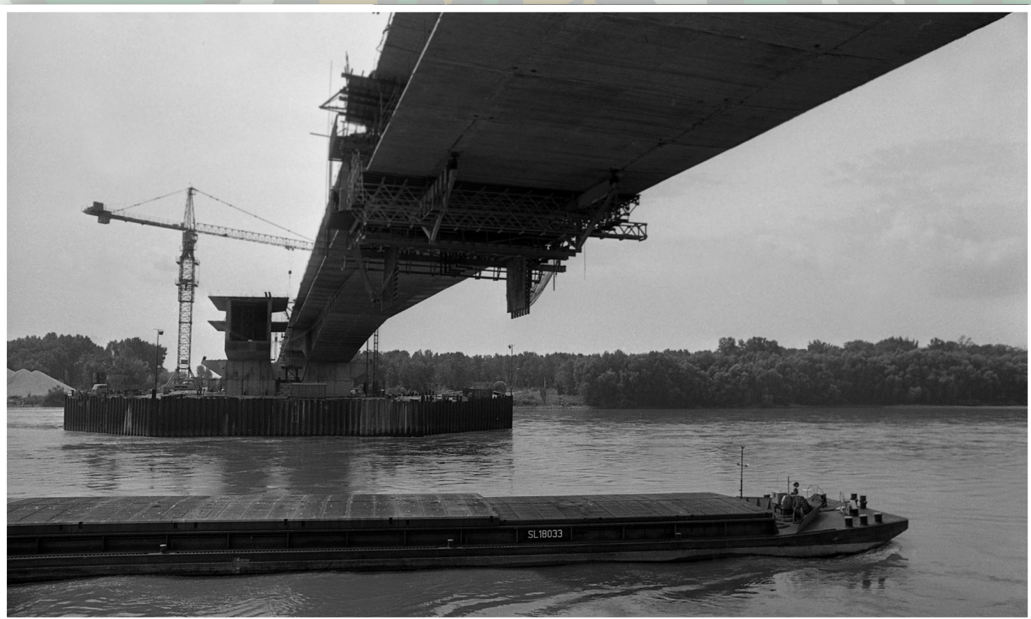
Most počas výstavby v auguste 1989
