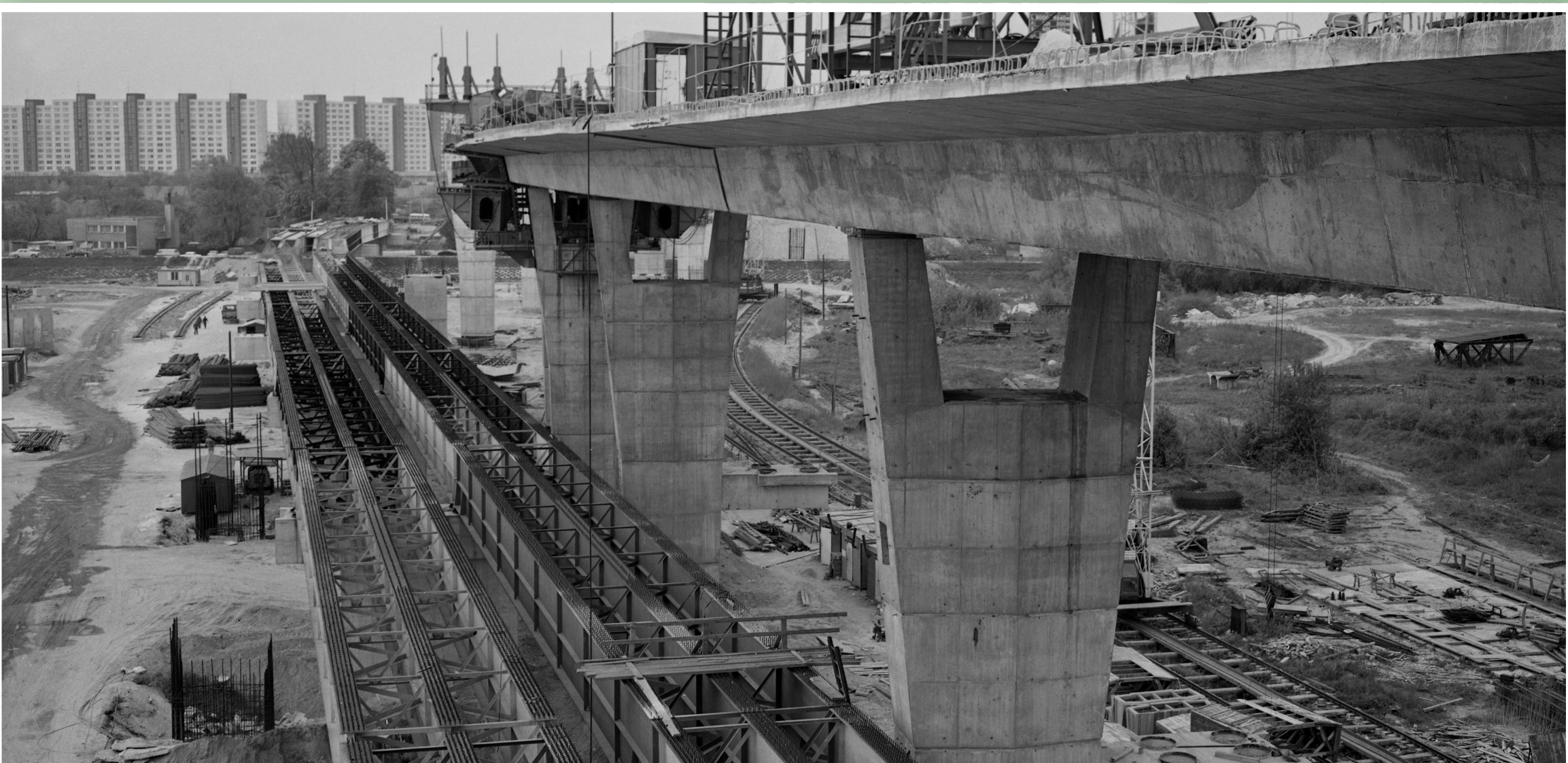
Pohľad na most počas výstavby v roku 1981
