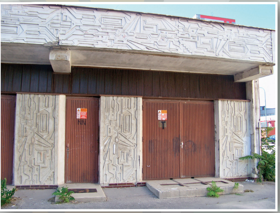
Obr. č. 8: Geometrické reliéfy Trafostanica, Bulíkova 27 Autor: Nezistený, koniec 70. rokov 20. stor.
