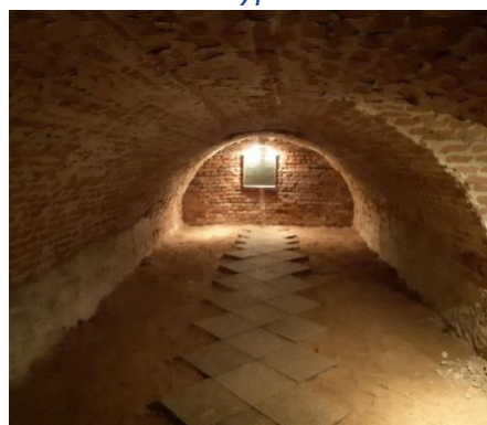
Podzemná časť krýpt
